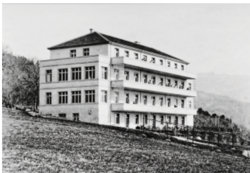
Der Tuberkulose-Pavillon Nadenbousch wurde im Jahr 1930 eröffnet: Es ist das erste Gebäude am heutigen Standort des Spitalzentrums im Vogelsang. zvg
