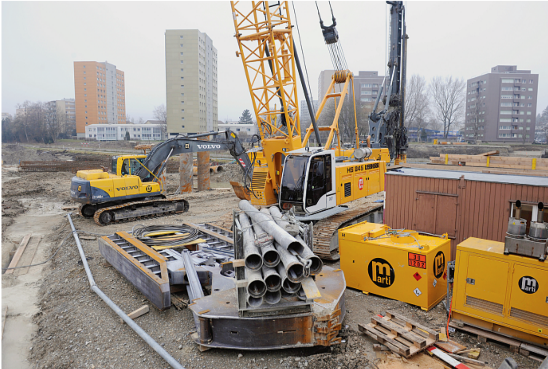
Der Ostast der A5-Umfahrung (hier im Brüggmoos) dürfte 2016 abgeschlossen sein. Er wird eine direkte Verbindung zum Industriegebiet im Bözingenfeld ermöglichen.
