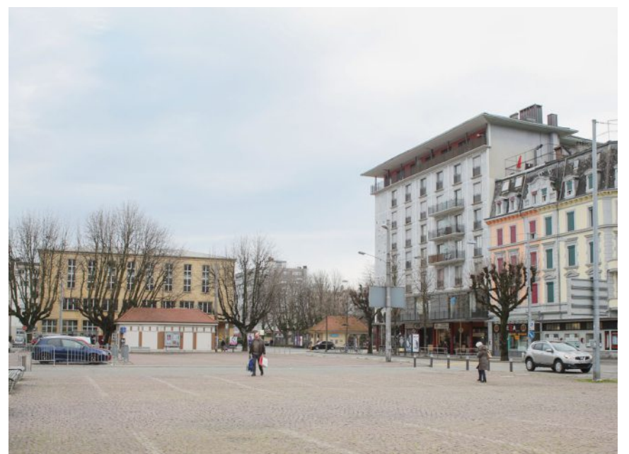
Le carrefour au centre de l'image ainsi que deux des quatre rues convergentes seront assainis. Le revêtement et la sécurité des usagers sont en cause. ARCHIVES/JULIE LOVENS
