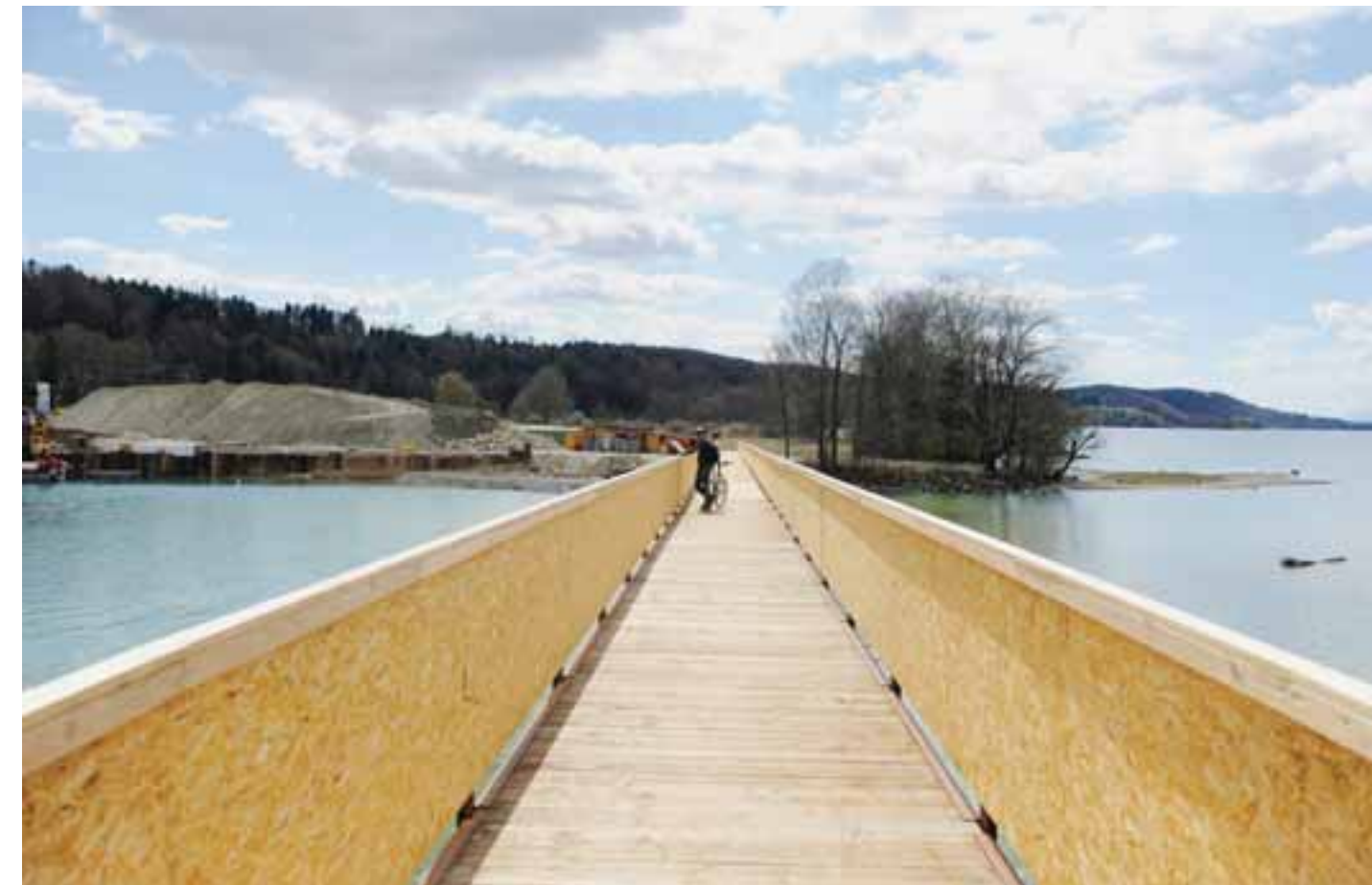
Leuchtend und «teuer wie Gold»: Das Brückenprovisorium beim Kraftwerk kostet alles in allem 400 000 Franken.
